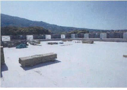
コンクリート下地
